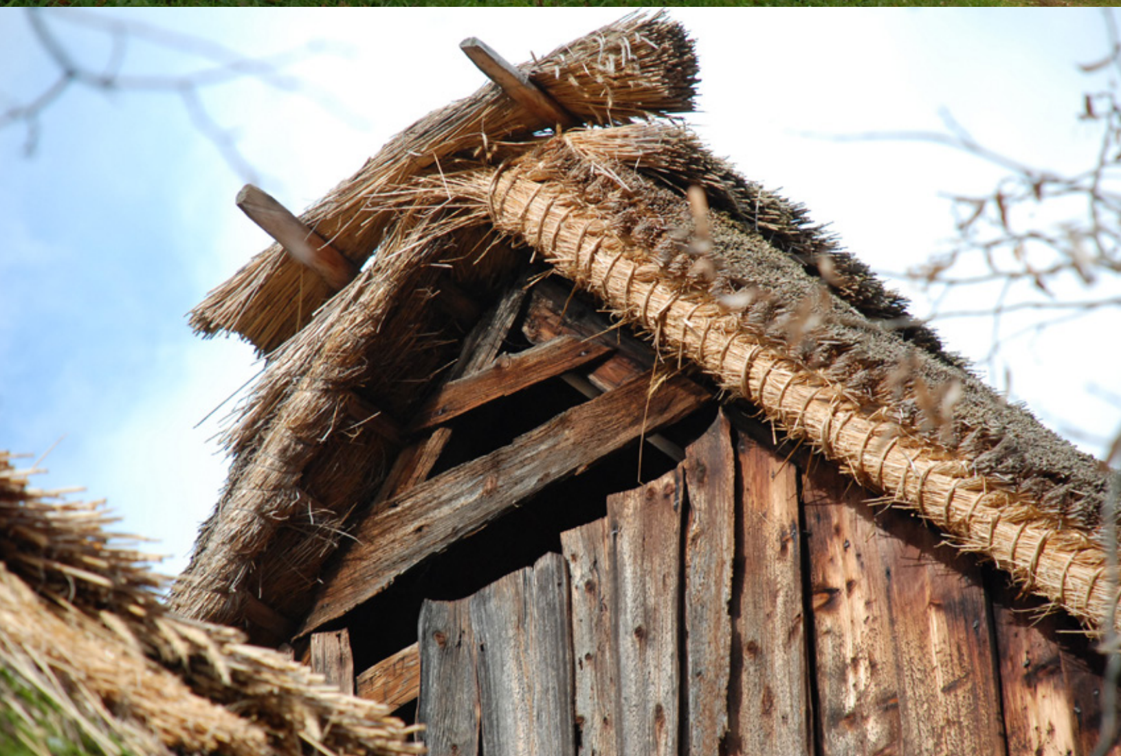
Zgoraj levo: Dolenji Novaki - Domačija Dolenji Novaki 5, EŠD 4768, zatrejni zaključek (foto: A. Ščukovi) Zgoraj desno: postopek prekrivanja strehe s slamo (foto: A. Ščukovi)
