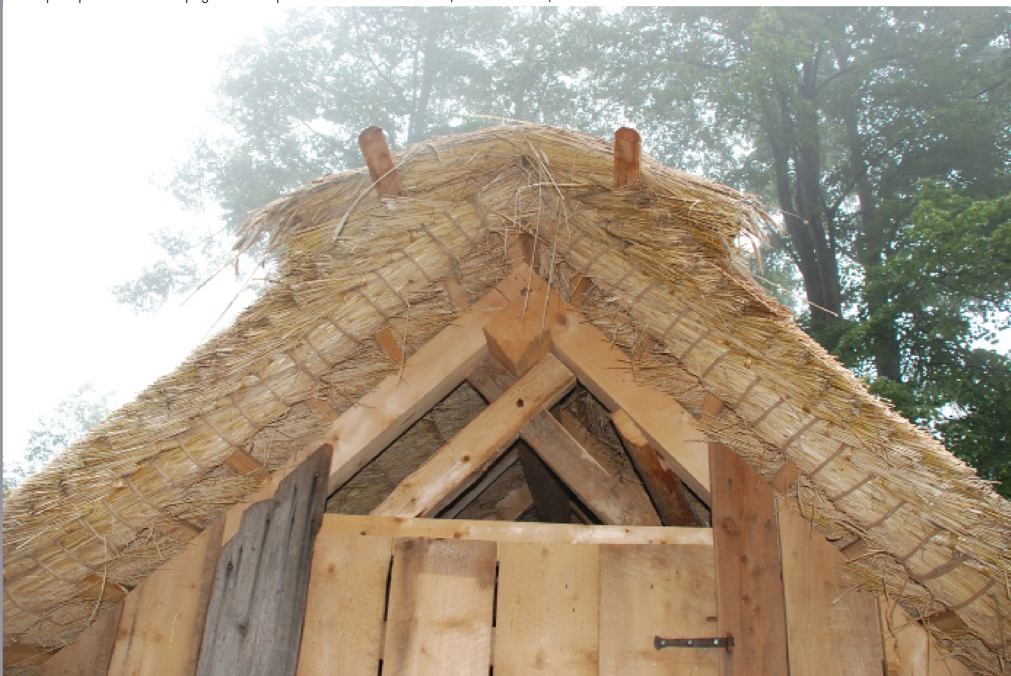
Spodaj: Kneške Ravne - pogled na zaključek slamnate strehe senika (foto: A. Ščukovič)
