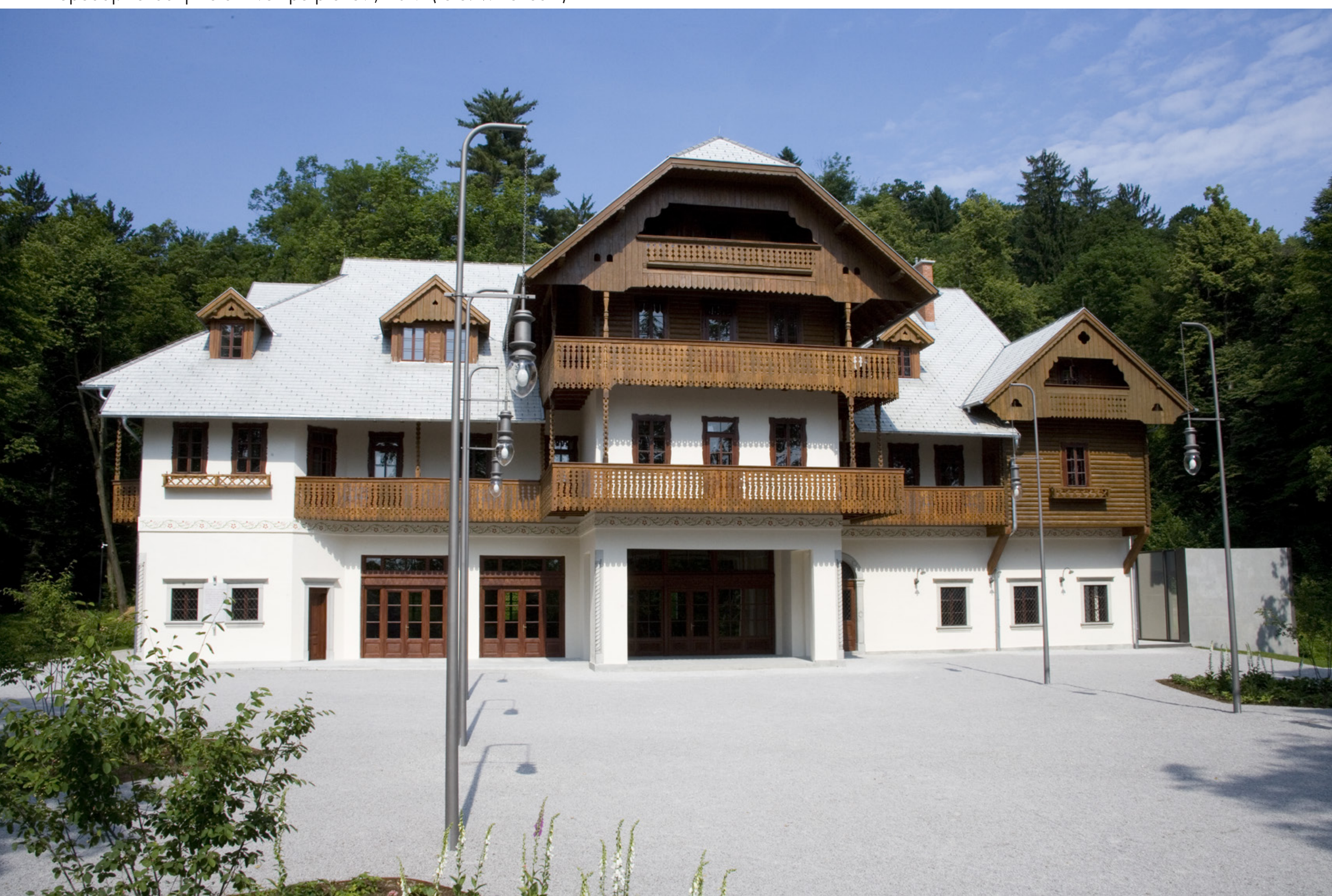
Spodaj: nekdanji hotel Tivoli po prenovi, 2017 (foto: V. Benedik)
