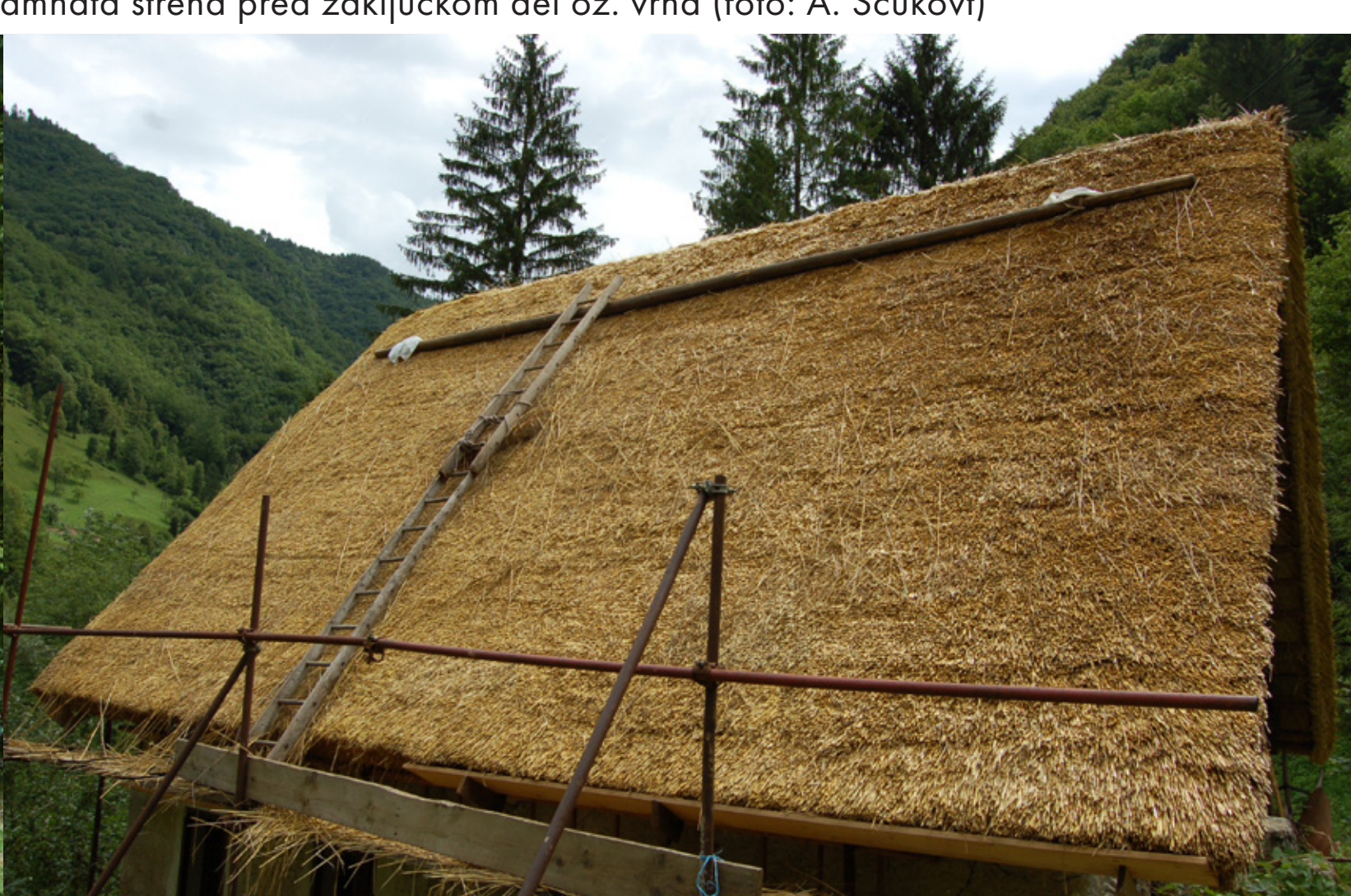
Spodaj levo: Dolenja Trebuša - Domačija Dolenja Trebuša 18, EŠD 14280, pogled na slamnato streho pred izdelavo vrha (foto: A. Ščukovi) Spodaj desno: Dolenja Trebuša - Domačija Dolenja Trebuša 18, EŠD 14280, slamnata streha pred zaključkom del oz. vrha (foto: A. Ščukovi)
