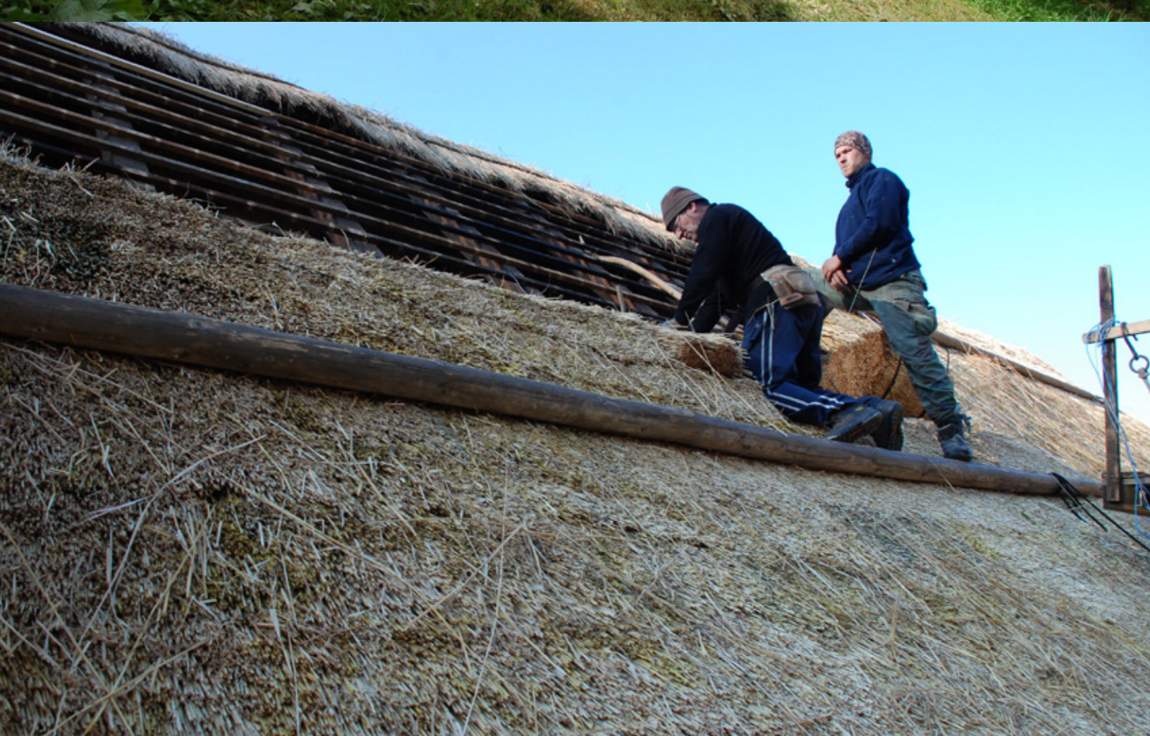
Zgoraj levo: Gorenja Trebuša - Domačija Gorenja Trebuša 112, 113, EŠD 5045 Slavko Šorli z vajencem med postopkom prekrivanja strehe (foto: A. Ščukovi) Zgoraj desno: Gorenja Trebuša - Domačija Gorenja Trebuša 112, 113, EŠD 5045 Slavko Šorli med prekrivanjem strehe (foto: A. Ščukovi) Spodaj levo: Podmelec - Kašča domačije Podmelec 49, EŠD 5062, perut in vrh strehe kašče - dotrajana in nova slamnata kritina (foto: A. Ščukovi)
