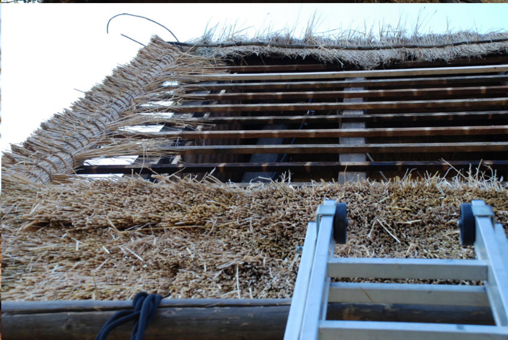
Zgoraj levo: Dolenji Novaki - Domačija Dolenji Novaki 5, EŠD 4768, zatrejni zaključek (foto: A. Ščukovi) Zgoraj desno: postopek prekrivanja strehe s slamo (foto: A. Ščukovi)
