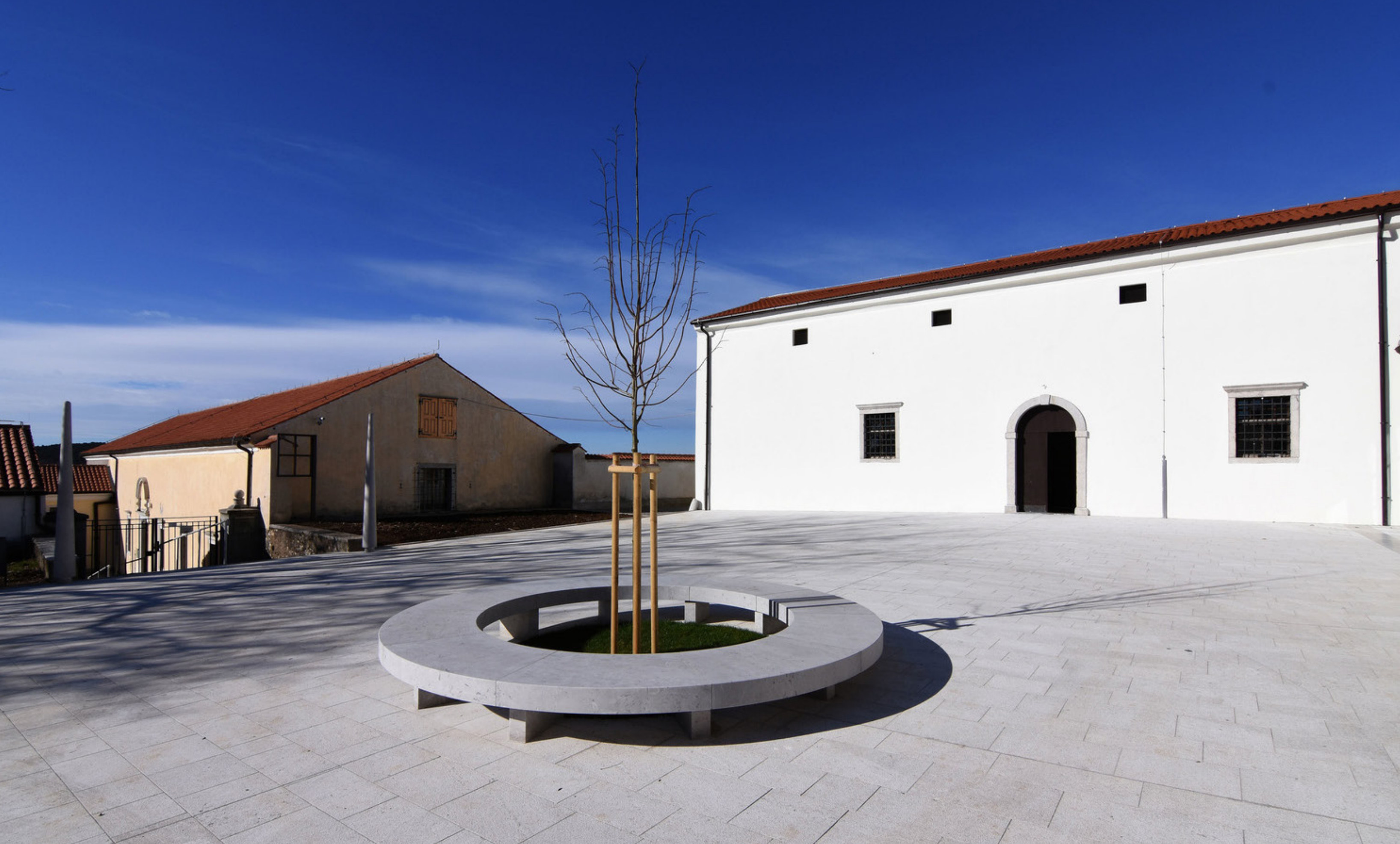
Obnovljen javni prostor (foto: M.Mljač, Draft arhitekti)
