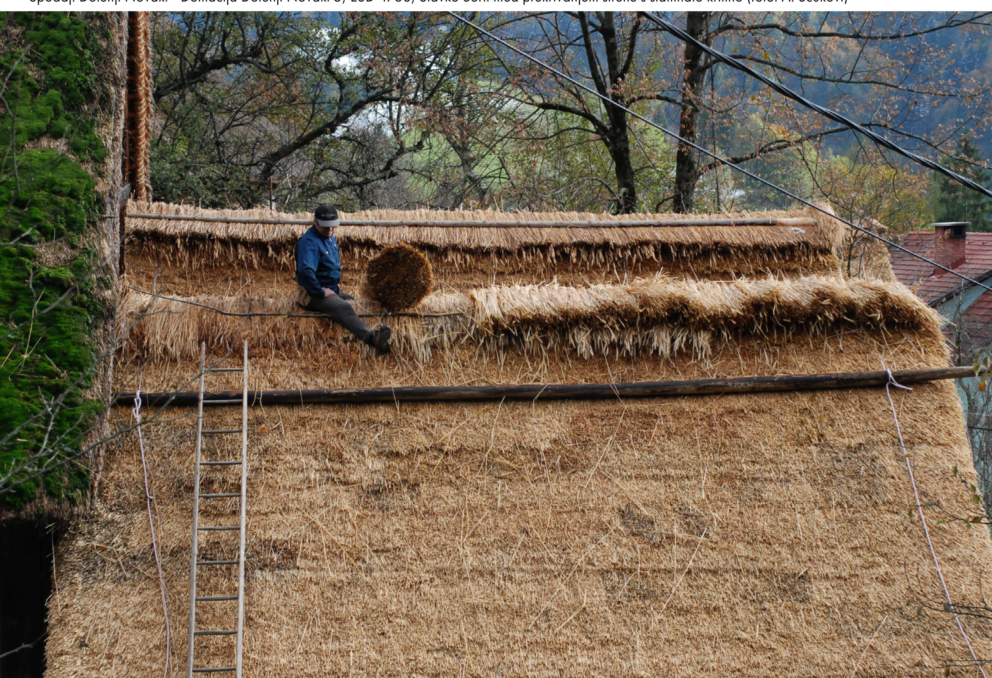
Spodaj: Dolenji Novaki - Domačija Dolenji Novaki 5, EŠD 4768, Slavko Šorli med prekrivanjem strehe s slamnato kritino (foto: A. Ščukovi)
