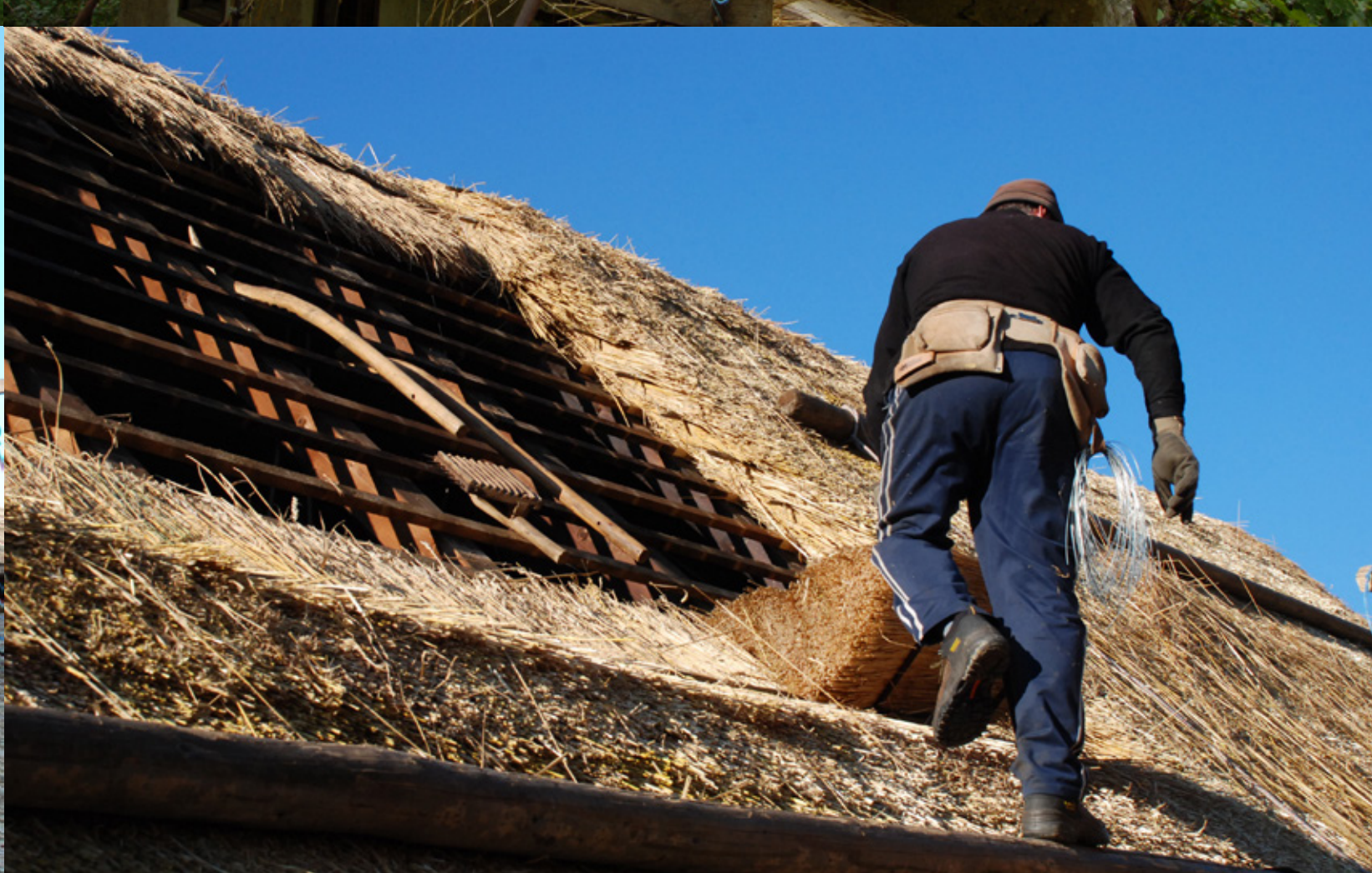
Zgoraj levo: Gorenja Trebuša - Domačija Gorenja Trebuša 112, 113, EŠD 5045 Slavko Šorli z vajencem med postopkom prekrivanja strehe (foto: A. Ščukovi) Zgoraj desno: Gorenja Trebuša - Domačija Gorenja Trebuša 112, 113, EŠD 5045 Slavko Šorli med prekrivanjem strehe (foto: A. Ščukovi) Spodaj levo: Podmelec - Kašča domačije Podmelec 49, EŠD 5062, perut in vrh strehe kašče - dotrajana in nova slamnata kritina (foto: A. Ščukovi)
