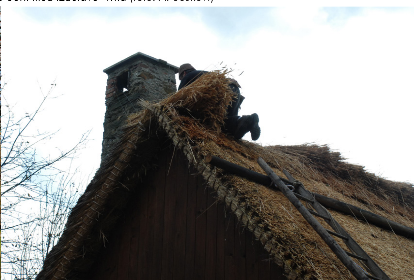
Spodaj levo: Dolenji Novaki - Domačija Dolenji Novaki 5, EŠD 4768, pogled na s slamo prekrivane strehe objektov domačije (foto: A. Ščukovi) Spodaj desno: Dolenji Novaki - Domačija Dolenji Novaki 5, EŠD 4768, Slavko Šorli med izdelavo vrha (foto: A. Ščukovi)
