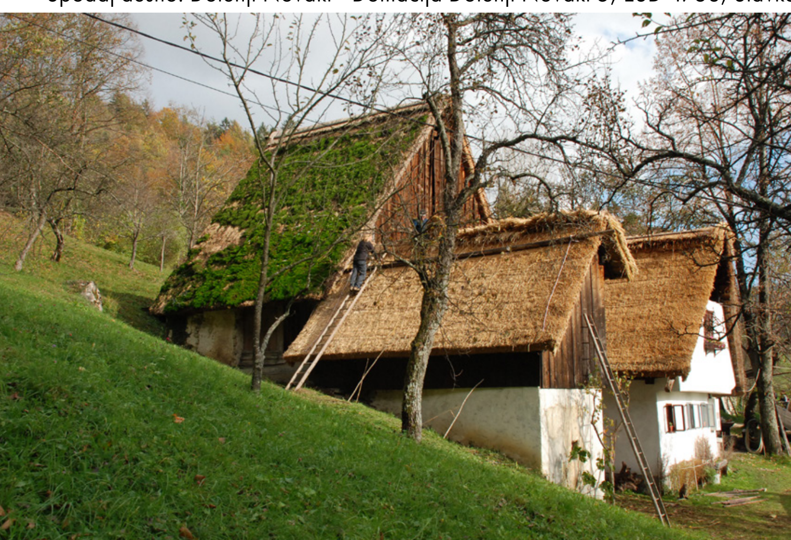
Spodaj levo: Dolenji Novaki - Domačija Dolenji Novaki 5, EŠD 4768, pogled na s slamo prekrivane strehe objektov domačije (foto: A. Ščukovi) Spodaj desno: Dolenji Novaki - Domačija Dolenji Novaki 5, EŠD 4768, Slavko Šorli med izdelavo vrha (foto: A. Ščukovi)
