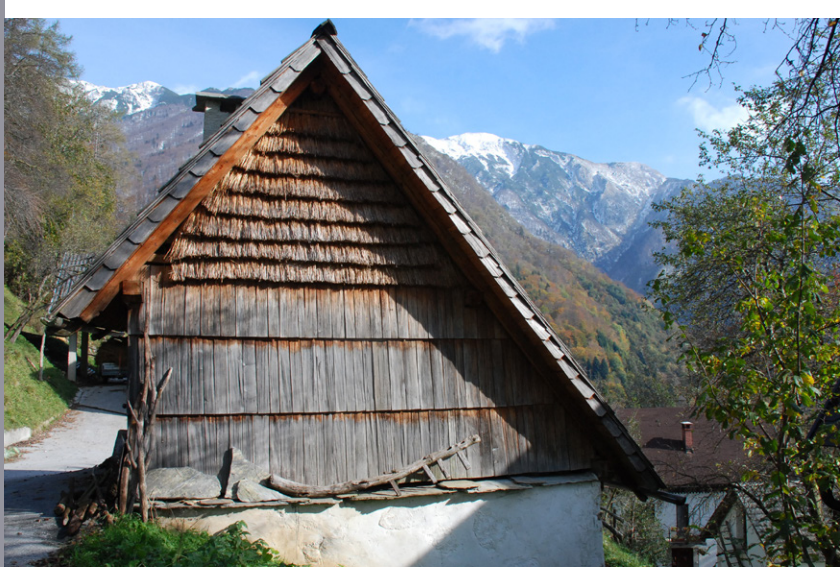
Od leve proti desni: Kneške Ravne - pogled na slamnat in leseni zatrep kašče (foto: M. Kunst), Kneške Ravne - pogled na leseno kaščo na zidani osnovi (foto: M. Kunst)
