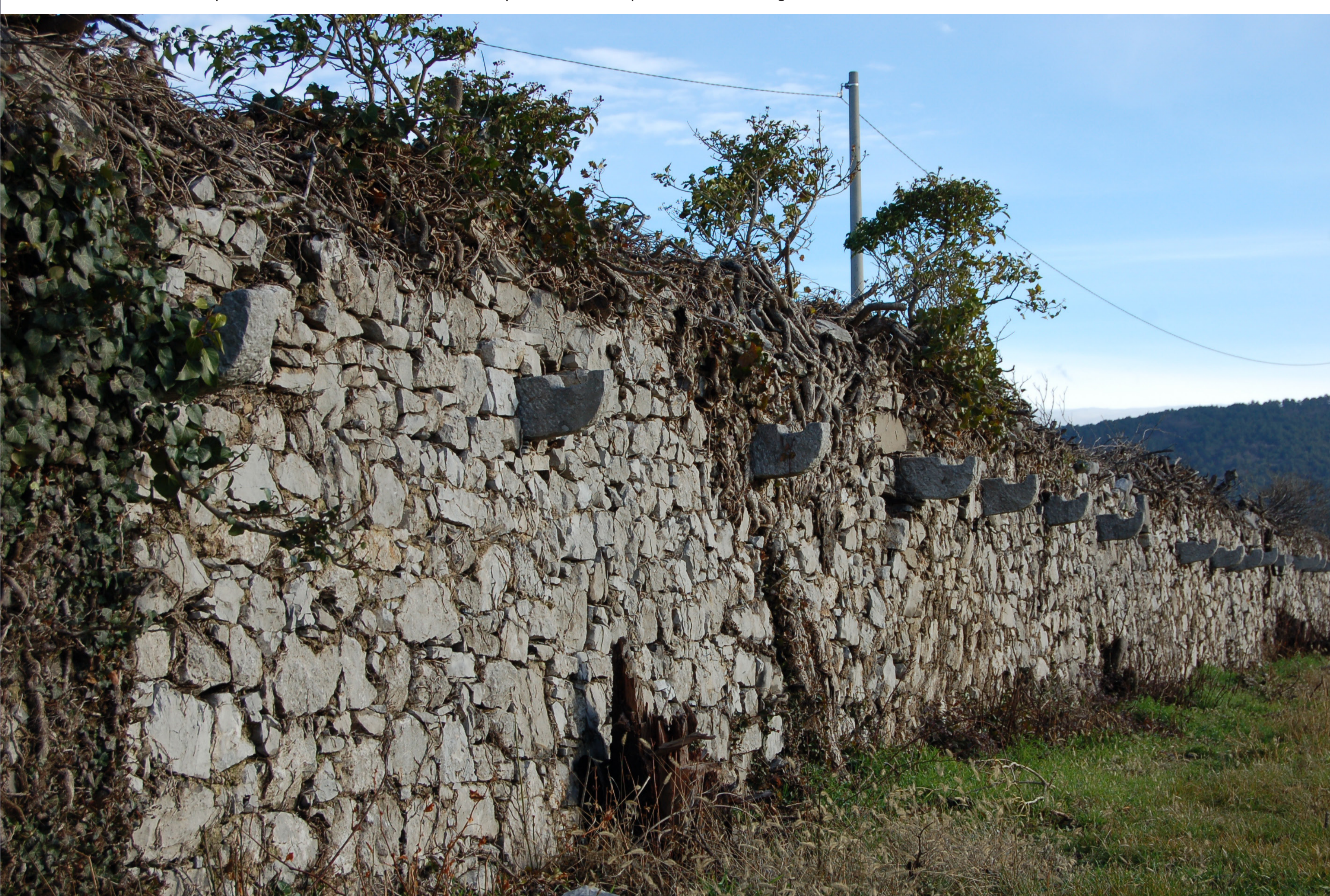
V visoki suhi zid vpete kamnite konzole so služile kot opora trtam, Štorje. (foto: Eda Belingar, 2018)
