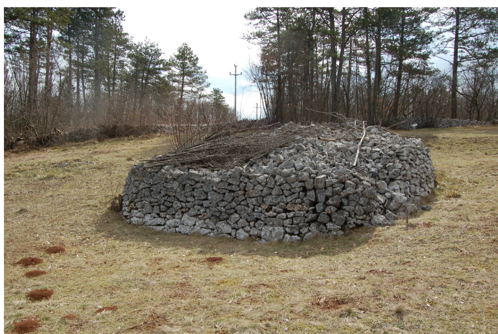
Levo: Očiščeno kamenje s parcel zavzame najmanj prostora in je najbolj stabilno v konstrukciji. Kupi odvečnega kamenja, griže, v Krtovi Prjevščini, Kosovelje. (foto: Eda Belingar, 2013) Desno: Griža s pozidanim obodom v Drejkavi ogradi, Pliskovica. (foto: Eda Belingar, 2013)
