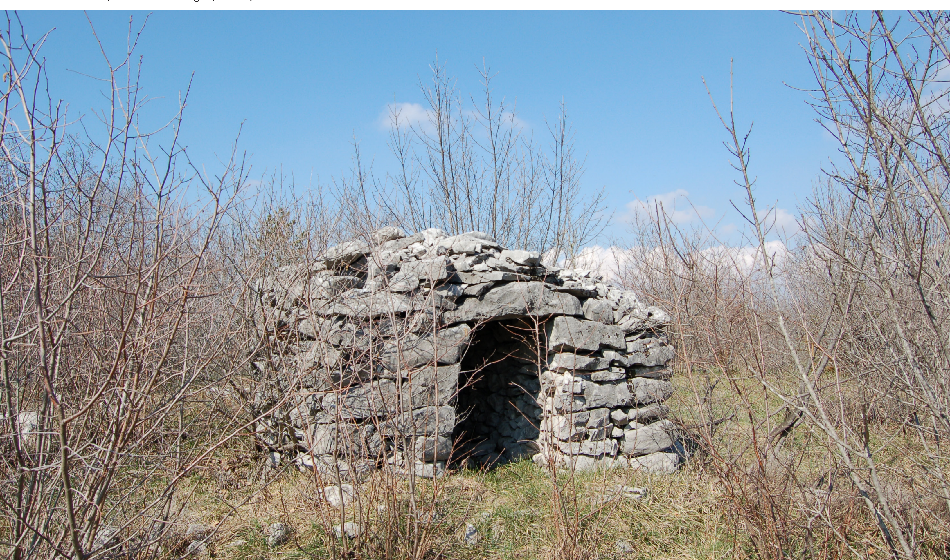
Hruševica, Jnkava samostojno stoječa hiška pri Pipnci na Kremeniki. Poleg mostov in cest so hiške najbolj dovršene gradnje, postavljene s suhozidno tehniko. (foto: Eda Belingar, 2013)
