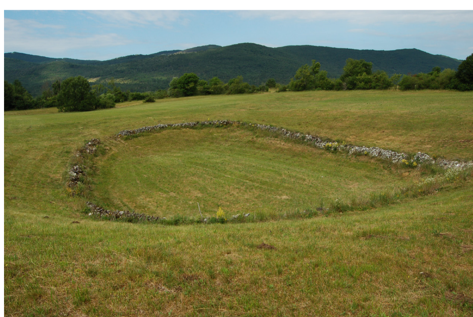
Levo: S podpornimi in mejnimi suhimi zidovi zaščitene obdelovalne površine pod vasjo, Dobravlje pri Tomaju. (foto Eda Belingar, 2014) Desno: Šabčeva ograda, zamejena z na suho pozidanim podpornim zidom, Povžane. (foto Eda Belingar, 2017)
