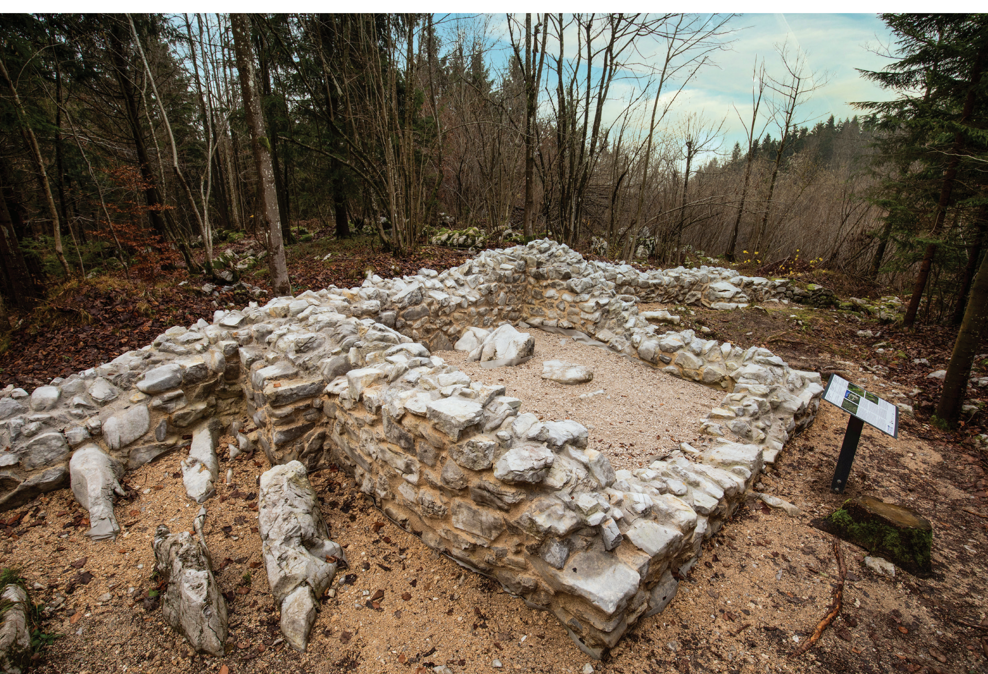
Ajdovski zid pri Vrhniki, prezentiran poznorimski stolp 44 pri Cesarskem vrhu (foto: Petar Fabijan, 2019)
