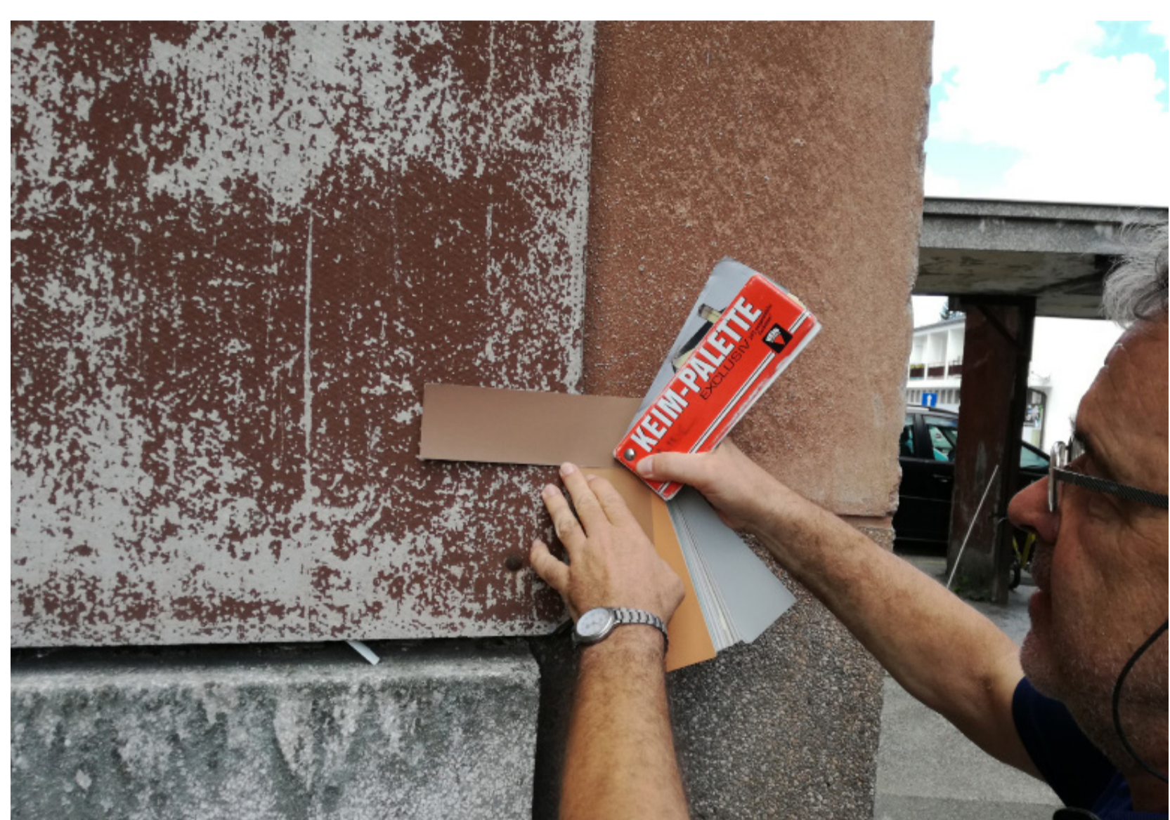
Levo: Objekt iz 20. stoletja na Cankarjevi ulici v Mariboru po opravljenih gradbenih posegih na fasadi (foto: Dr. Eva Sapač, 2017) Desno: Sondiranje in primerjava barvnih tonov na objektu 20. stoletja na Dvorakovi ulici v Mariboru (foto: Dr. Eva Sapač, 2017)
