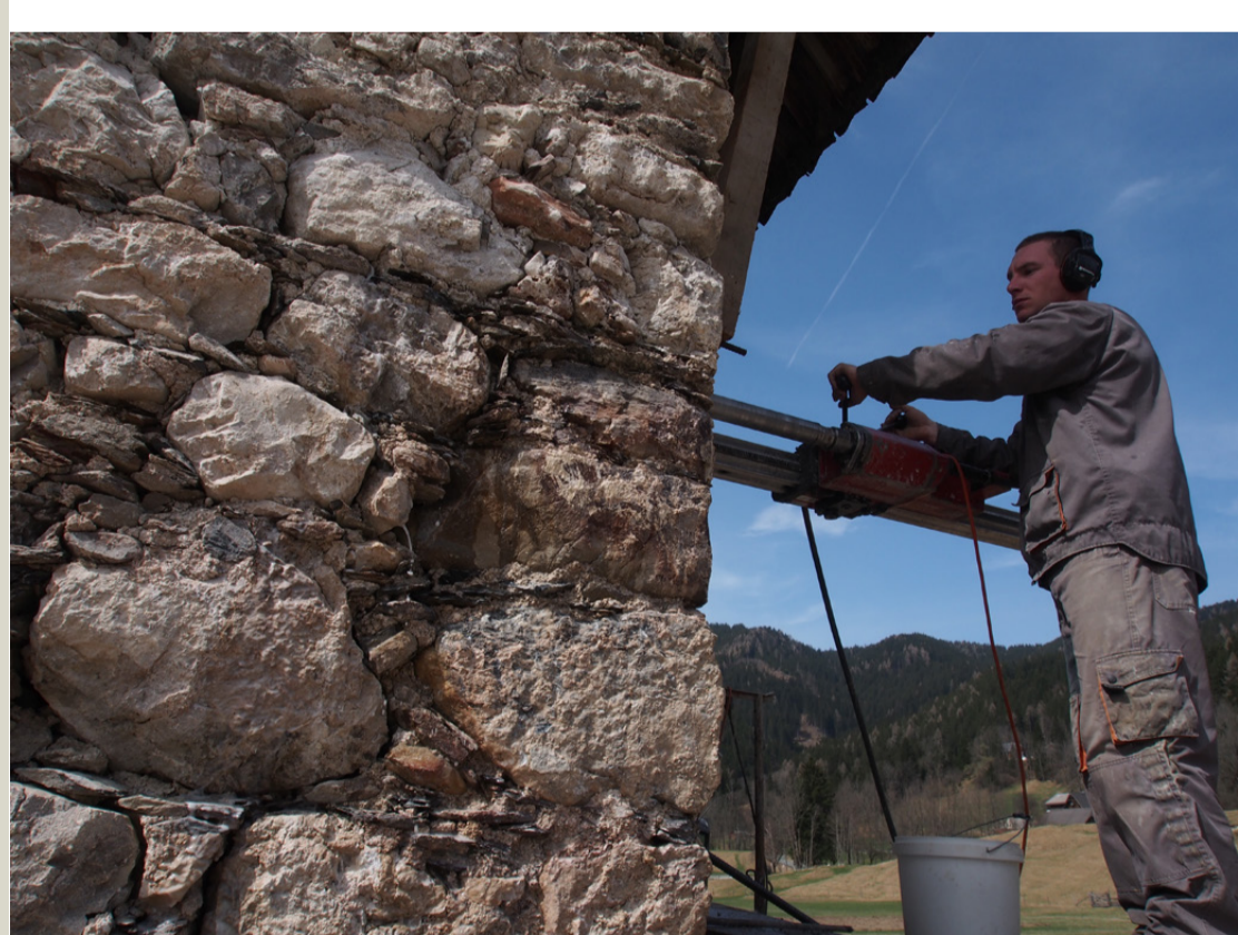
Levo: Sanacija stare hiše (foto: Drejc Karničar, 2016)
