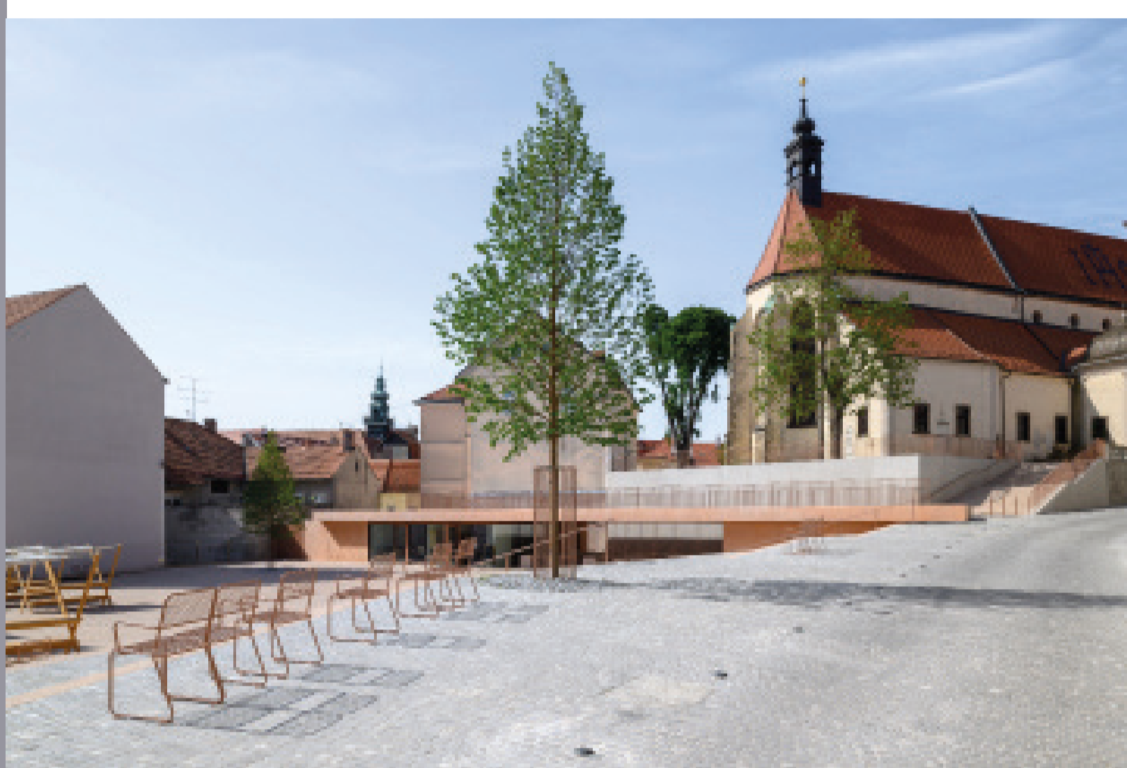
Levo in desno: Pokriti del tržnice je izveden iz rdečega betona, ki tonsko posnema opečnate strehe in se likovno poenoti z okolico. (vir: Arhitektura Krušec, foto Miran Kambič, 2021)
