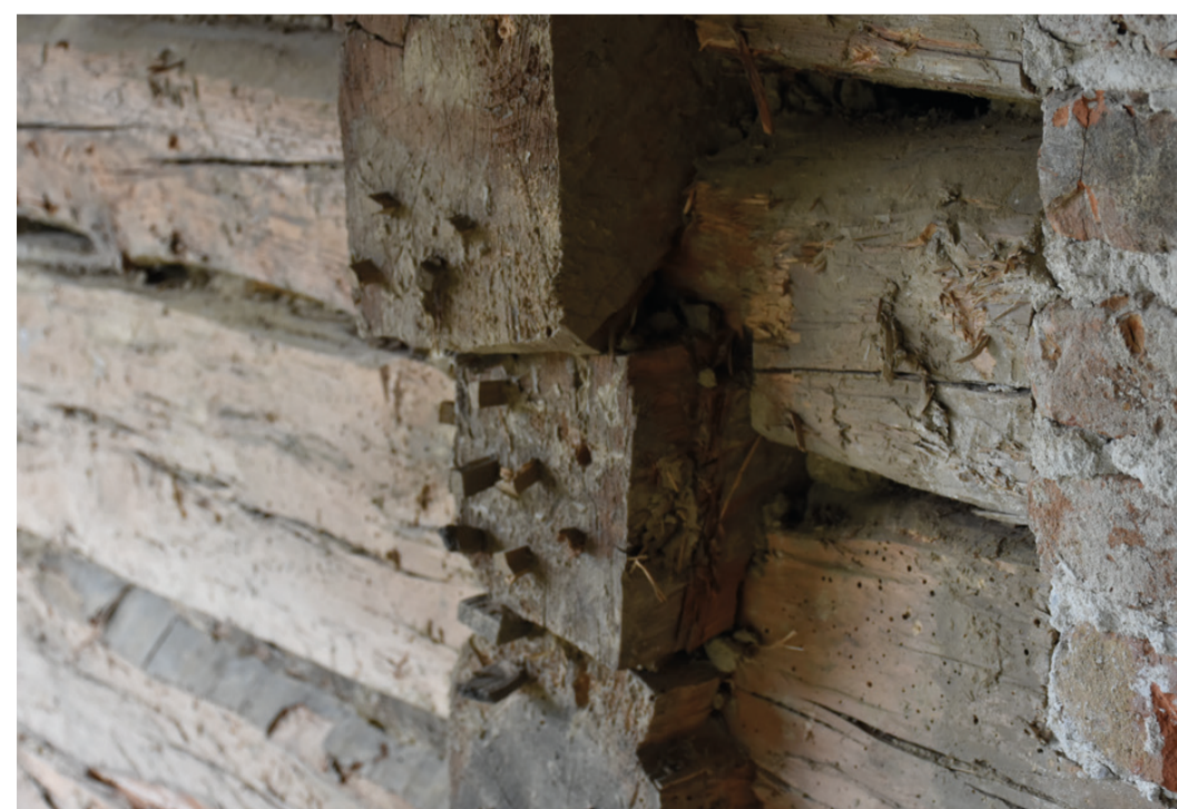
Detalji gradnje iz različnih lokalnih gradiv od leve proti desni: butana gradnja (levo), gradnja iz opeke sušene na soncu (sredina) in kladna konstrukcija (desno) (foto: Barbara Lečnik, 2020).
