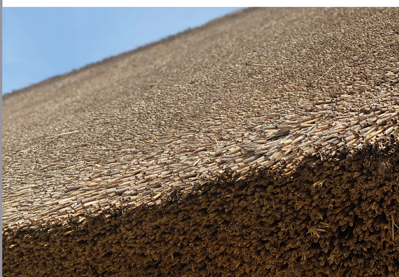
Desno spodaj: Detalj strešne konstrukcije (foto: Barbara Lečnik, arhiv ZVKDS OE Maribor, 2020)
